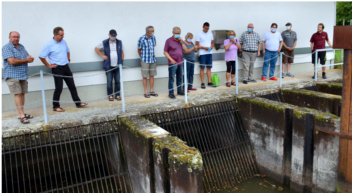
Die Mitglieder der Lorscher SPD am Überlaufbecken zum Pumpwerk, v.l., Bauamtsleiter Volker Knaup, Bürgermeister Christian Schöning, ganz rechts der SPD-Fraktionsvorsitzende Dirk Sander und Dipl. Bau-Ing. Andreas Stolz, Leiter des Kläranlagenbetriebs.
