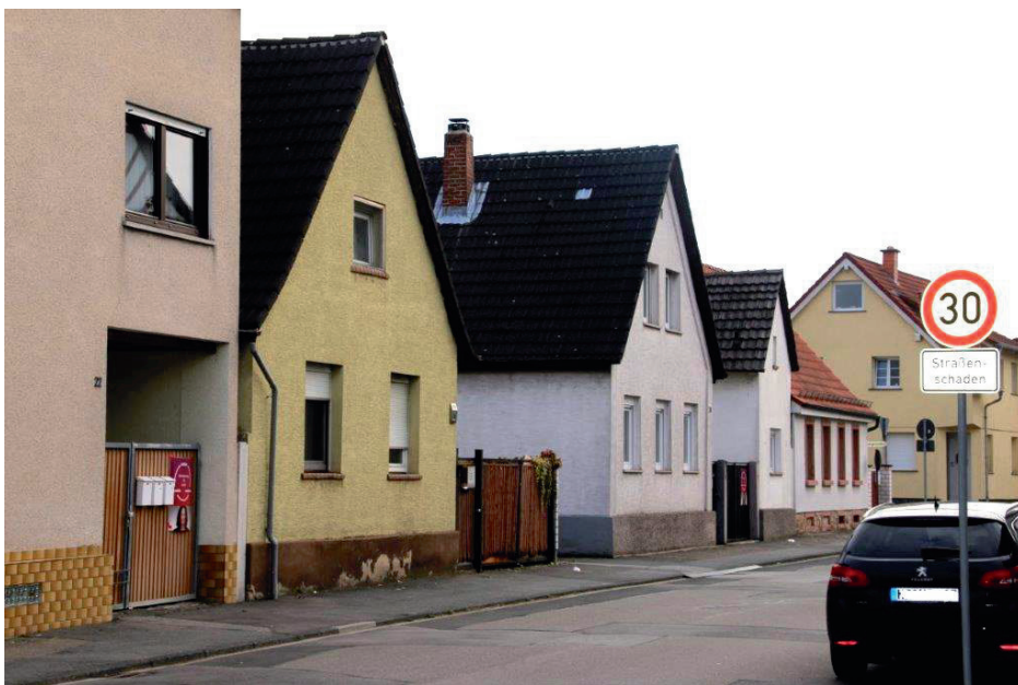
Der Zustand der Hirschstrasse wird immer schlechter
